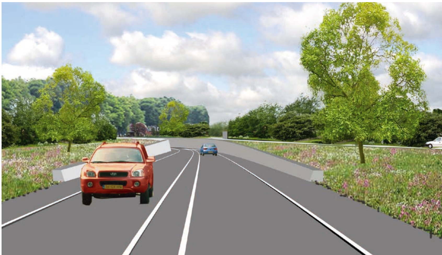
aan de westzijde van Noordhorn een compacte insnijding met keerwanden
